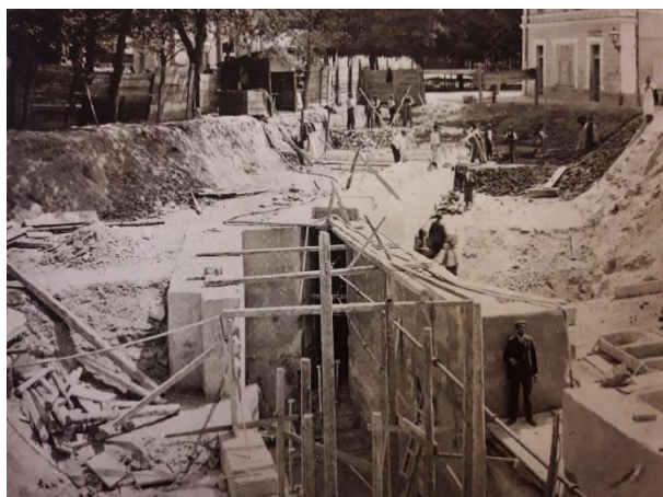
Slika 5: Betoniranje Knetteuma pomladi 1908 (Čoh str. 31, 2008)
